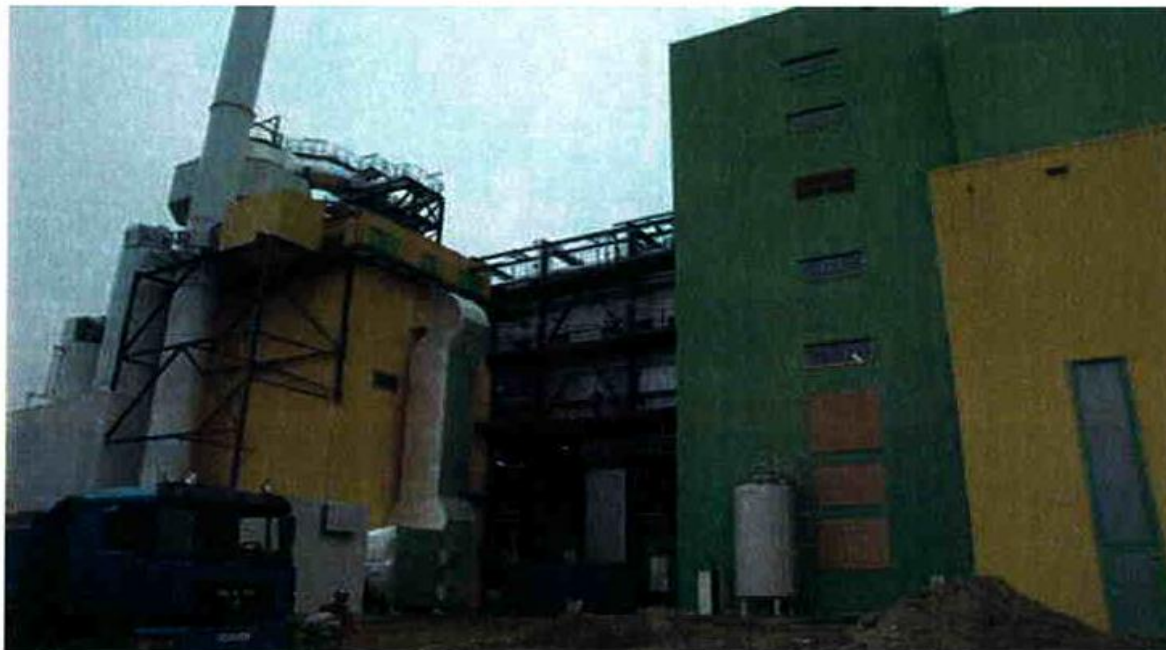
Neues EBS-Kraftwerk Stavenhagen
